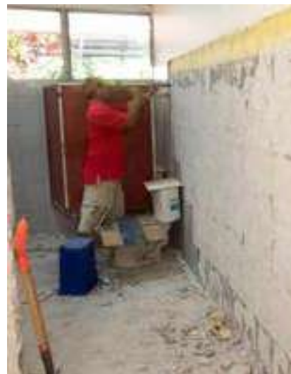
● Inician los trabajos de remodelación de los servicios sanitarios de la Escuela Francisco González Bocanegra.
